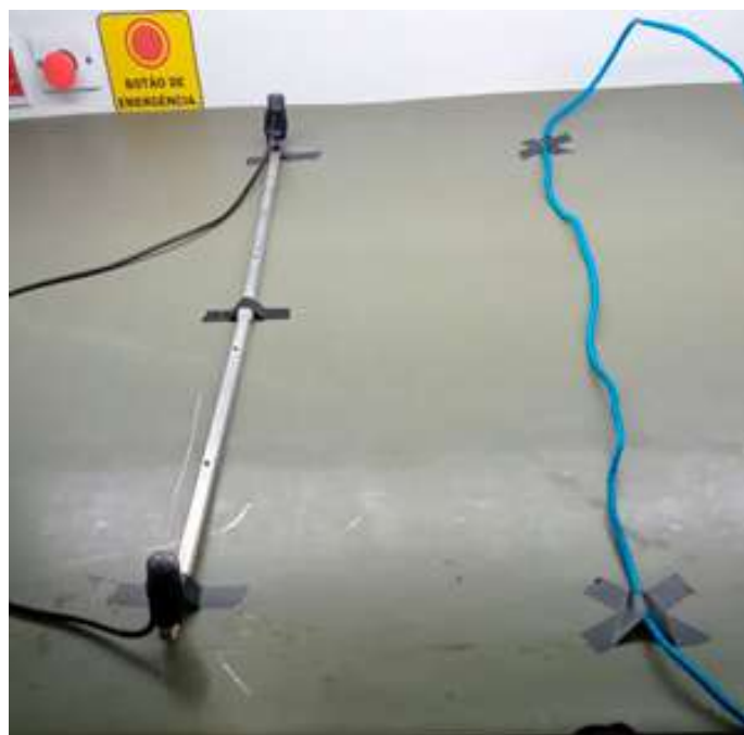
Figura 14 – Cabo vítima à uma distância média de trinta centímetros.
