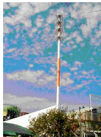
Figura 36. Torre de telefonia e antenas
