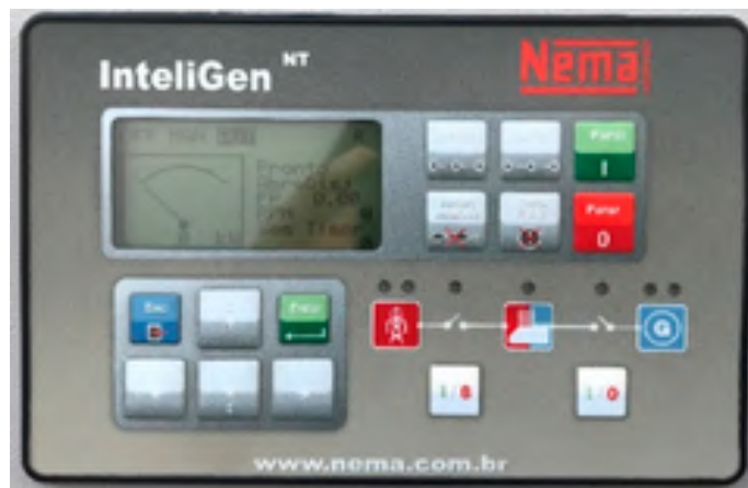
Figura 3 Módulo de controle de gerador ComAp IntelliGen NT.
