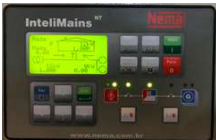
Figura 2 Controlador ComAp IntelliMains NT.
