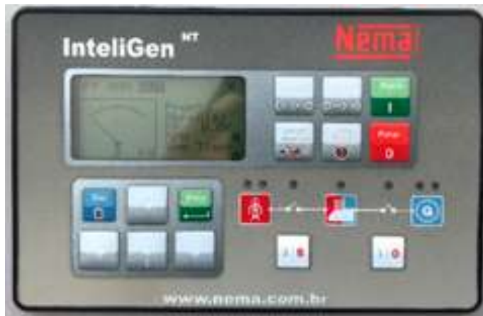
Figura 3 Módulo de controle de gerador ComAp IntelliGen NT.
